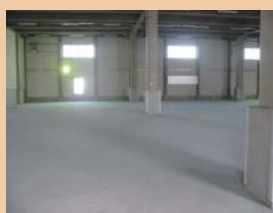
コンクリート打設1ヶ月後
